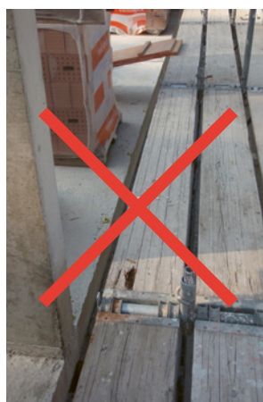
Fig. 2 et 3 Les platelages entaillés ou endommagés doivent être remplacés.
