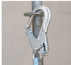
5 et 6 Les mousquetons doivent être fixés verticalement et ne pas être sollicités transversalement.
