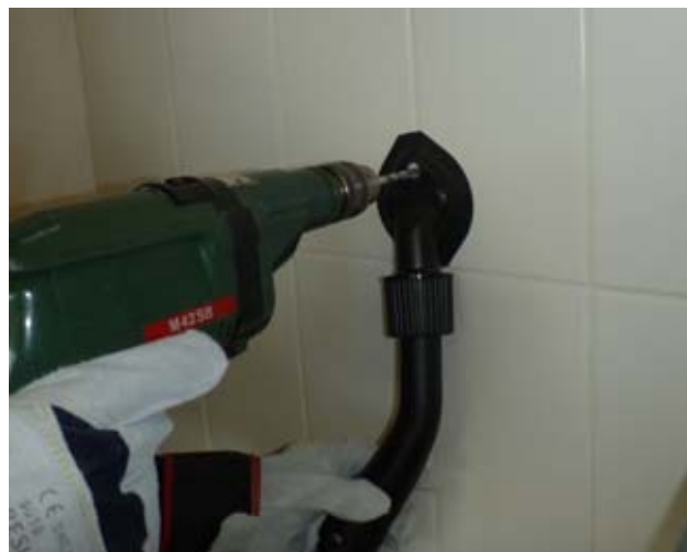
4 Perceuse avec aspiration à la source pour les carreaux en céramique comportant de la colle amiantée.
