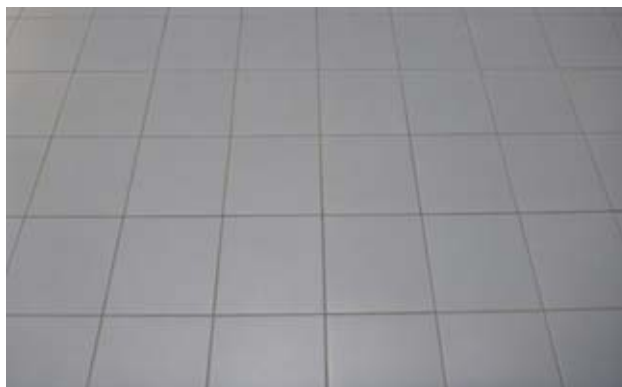
1 La colle à carrelage utilisée avant 1990 peut contenir de l'amiante.
