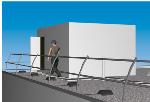
16 Toit plat avec garde-corps périphérique
