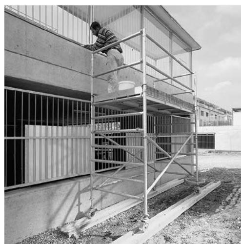
2 Un support résistant empêche l'échafaudage roulant de s'enfoncer brutalement.
