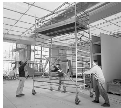
5 L'échafaudage roulant ne doit pas être déplacé lorsque des personnes se trouvent dessus.
