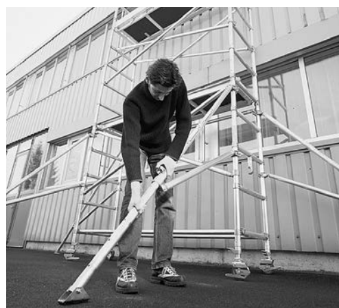
3 La notice de montage indique à partir de quelle hauteur et comment les appuis doivent être installés.
