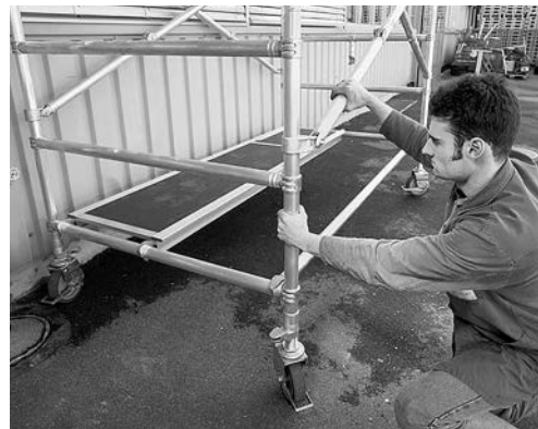
1 Des échafaudages roulants en bon état sont une condition sine qua non pour un travail sûr.
