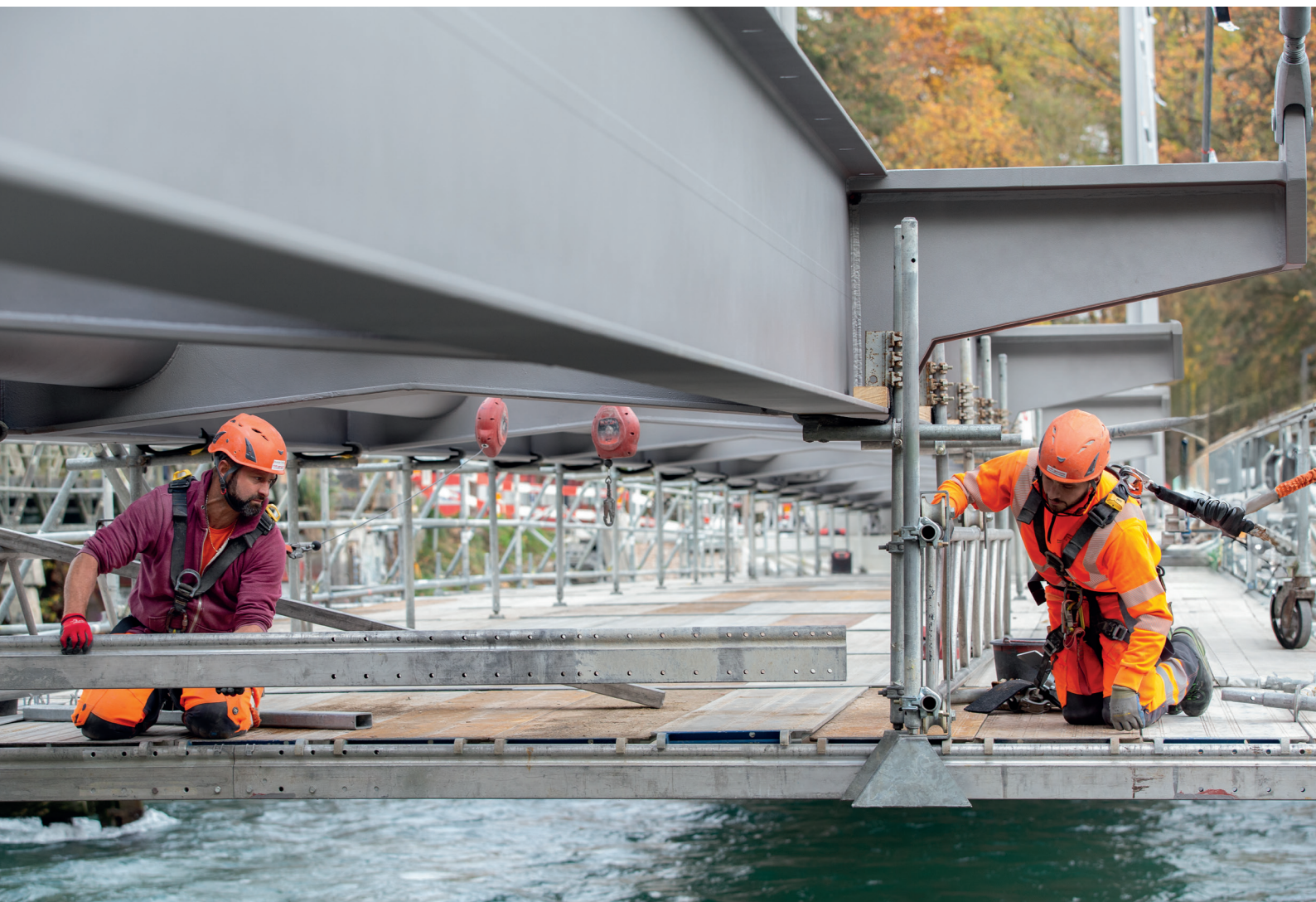
Abb. 5: Teamwork - Hängegerüst in Münsingen, Foto - eigene Aufnahme, 2024
