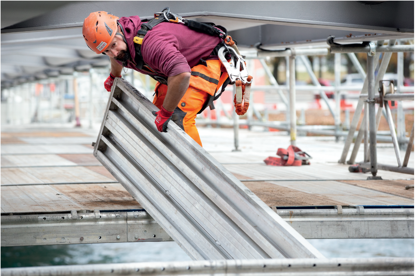
Abb. 6: Belag montieren - Hängegerüst, Foto - eigene Aufnahme, 2024
