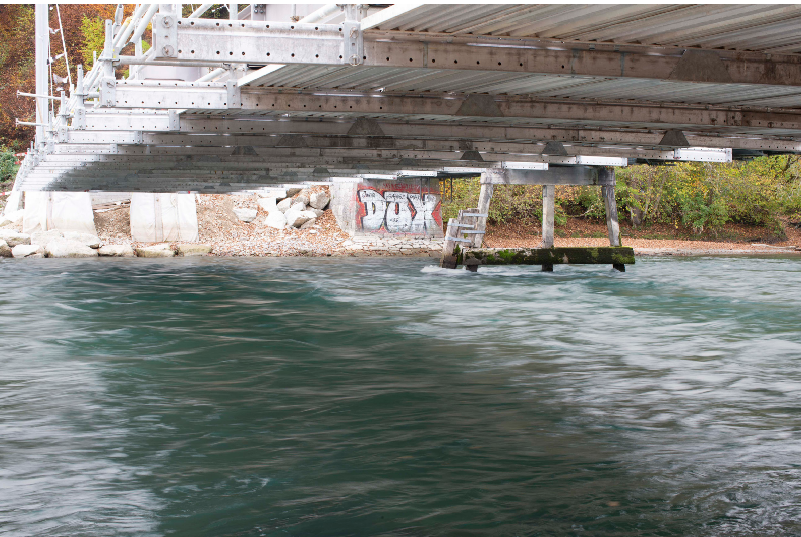
Abb. 8: Hängebrücke - Aare Münsingen, Foto - eigene Aufnahme 2024
